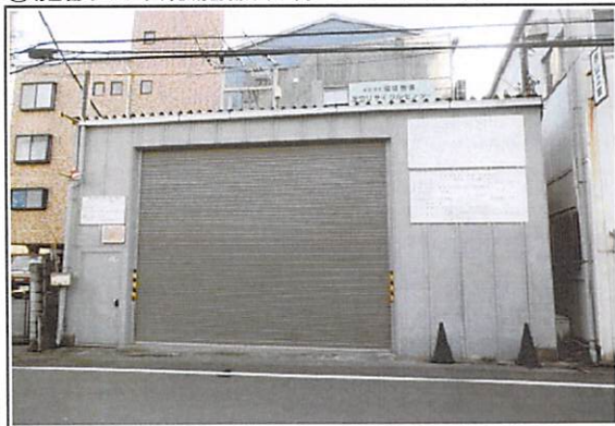
①施設の外觀(施設名称:足立リサイクルセンター)
