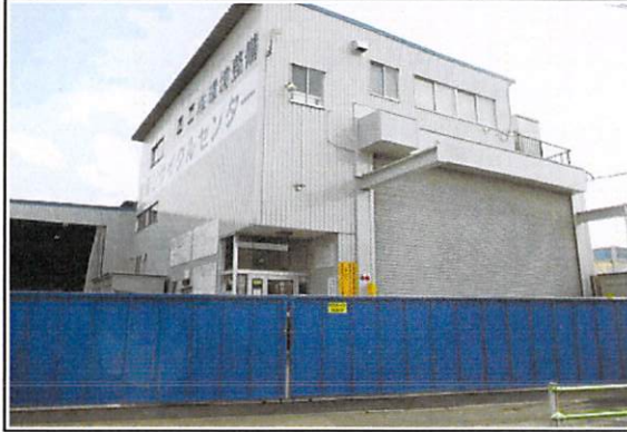
①施設の外観(施設名称:葛飾リサイクルセンター)
