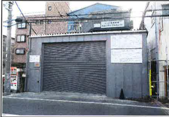
①施設の外観(施設名称:足立リサイクルセンター)
